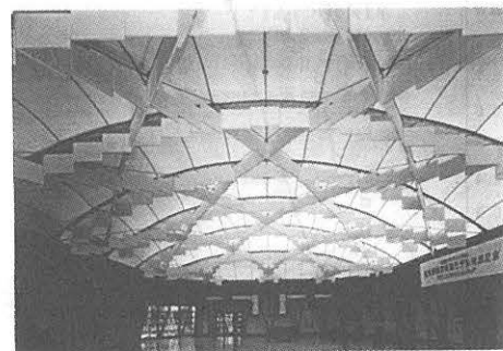
写真-2 空気膜実験棟内部 (吸音体を見る)
