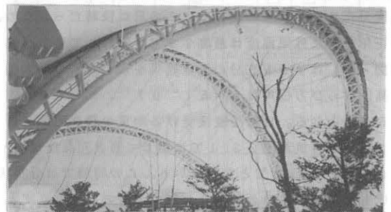
（写真-1）建物外観および内観
